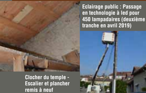
Réfection de la rue du Lorday avec création d'un trottoir
