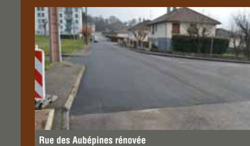
Rue des Aubépines rénovée
